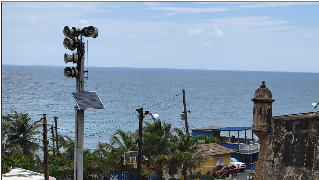
Figura 16: Ejemplo de sirena fija costera, instalada en La Perla, Municipio de San Juan.
